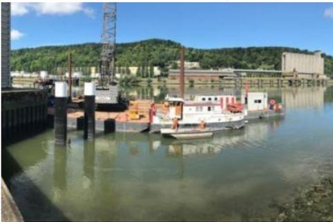
Les travaux, qui ont démarré le 7 juin 2021, consistent à sécuriser l'accostage sur le secteur amont exploité par le groupe BZ (Beuzelin) grâce à la construction d'un Duc d'Albe (pieux).
