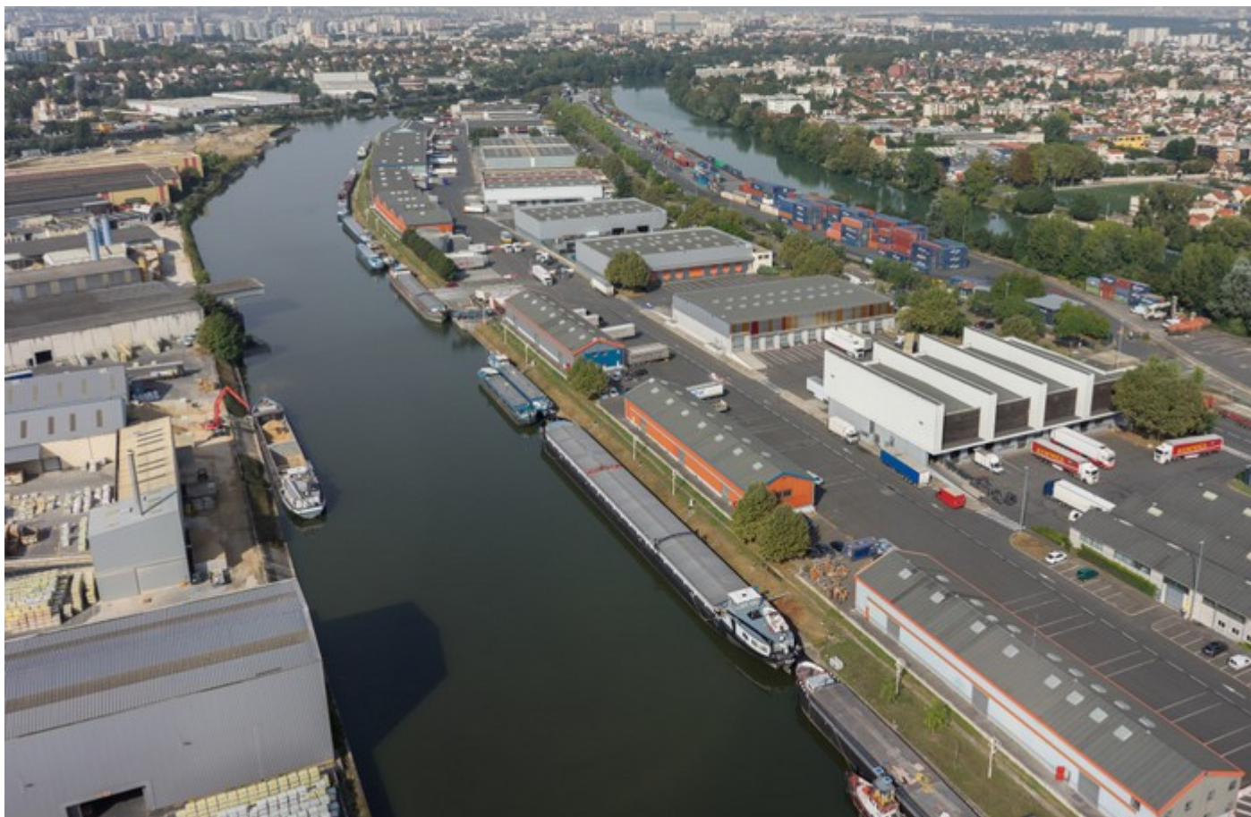
Vue aérienne du port de Bonneuil-sur-Marne. © HAROPA PORT
