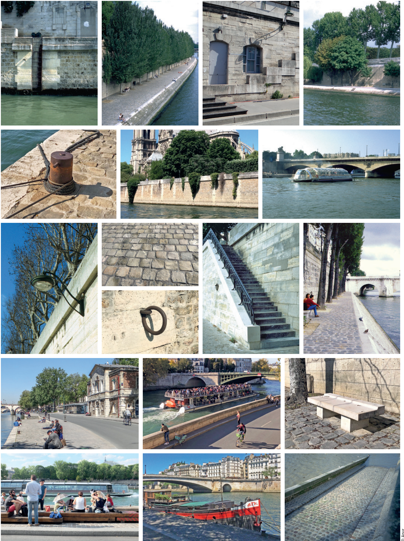
De haut en bas et de gauche à droite : échelle de quai • quai sur perré • locaux dans le mur de fond de quai • végétalisation étagée • bollard • mur de quai haut harpé • bateau de transport de passagers • luminaire sur mur de fond de quai • pavés de grès • anneau d'amarrage • escalier quai haut/quai bas • berges étroites • pavillon des Célestins • bateau de croisières commentées • banc berges de Seine • animation des berges • bateaux logement • rampes de mise à l'eau.
