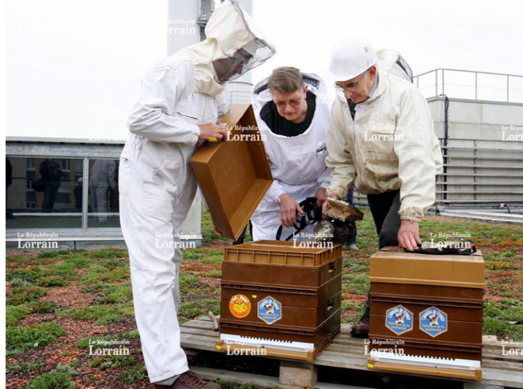
Ruchers sur le toit d'une chaufferie biomasse, Vandoeuvre
