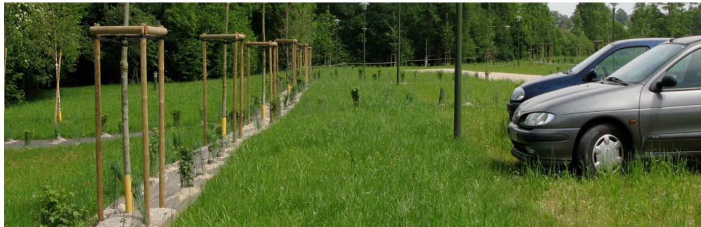
Parking sur prairie renforcée (engazonnement sur mélange terre-pierre compacté) adapté à une faible fréquentation.
