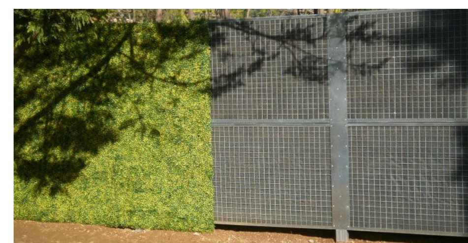
CLÔTURE ANTIBRUIT EN ACIER GALVANISÉ, VÉGÉTALISÉE (FABRICANT : «CLÔTURE ANTIBRUIT CIP»)
