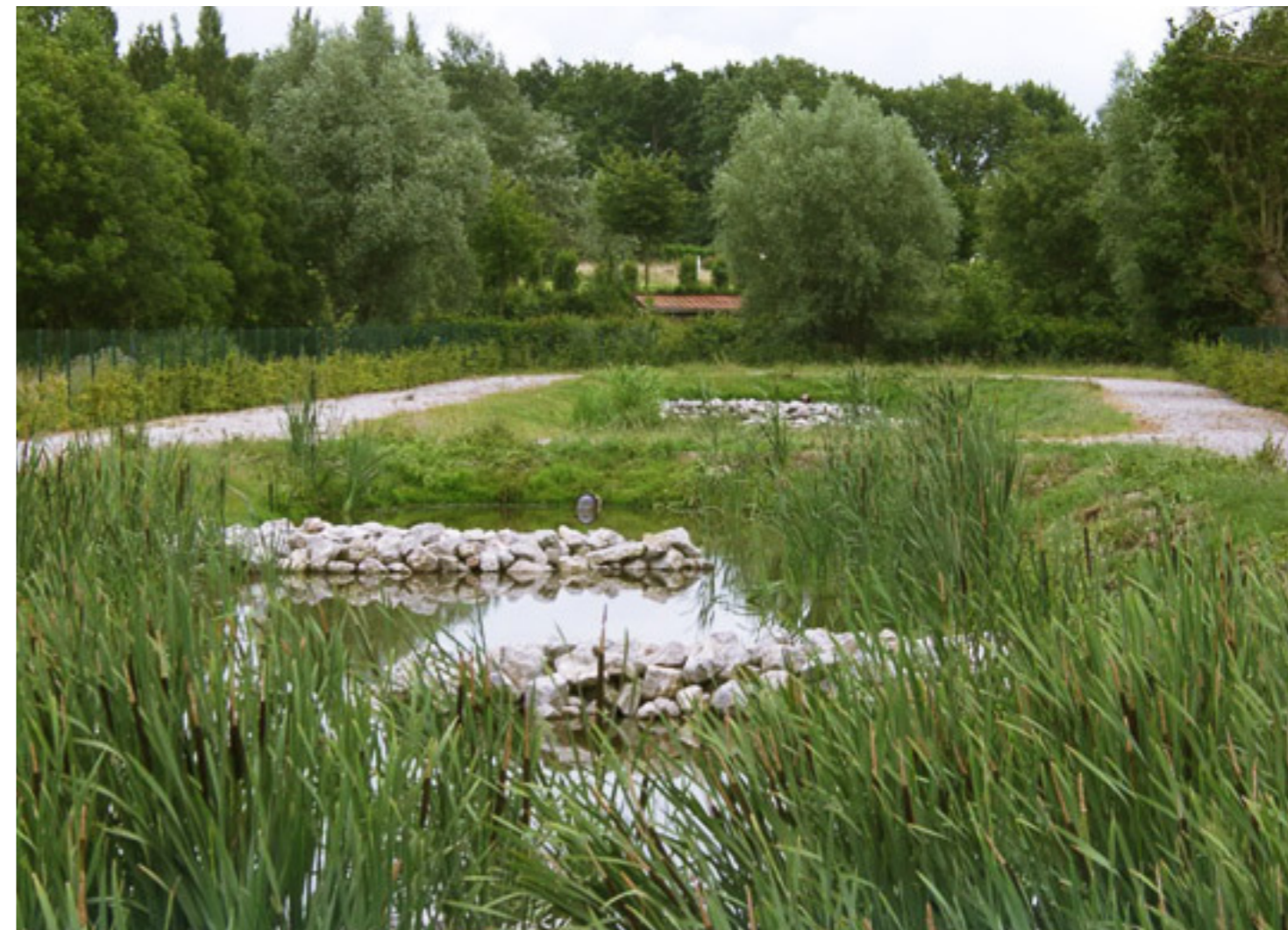
Exemple de bassin dépolluant
