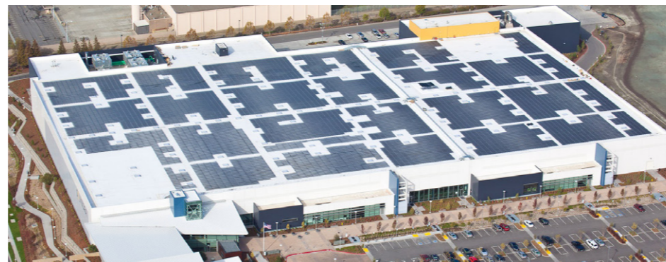
INSTALLATION DE PANNEAUX PHOTOVOLTAÏQUES EN TOITURE D'UN BÂTIMENT INDUSTRIEL
