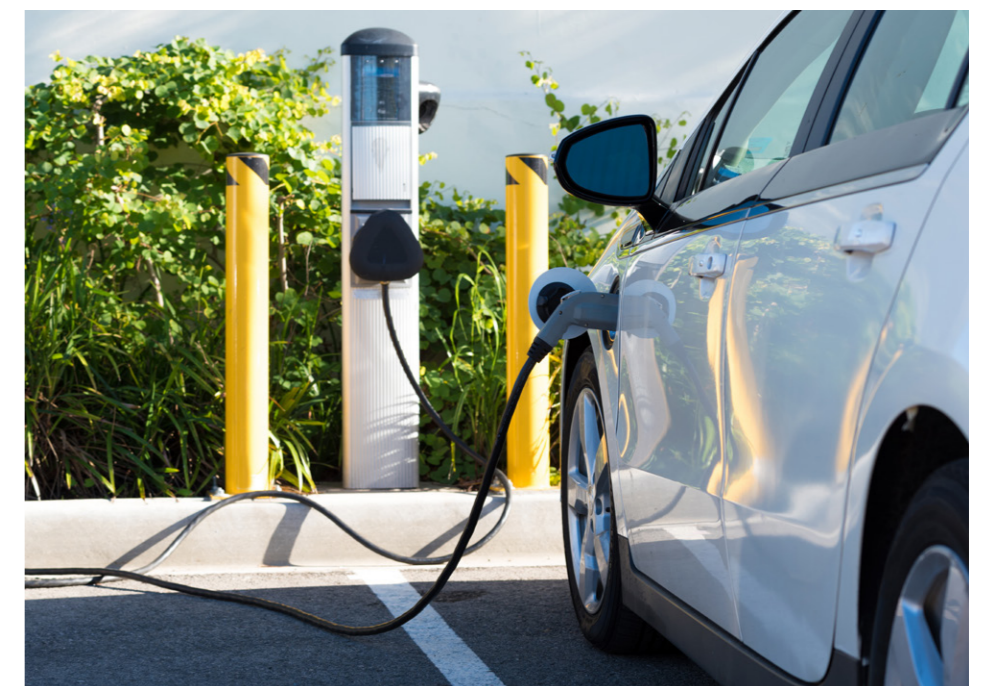
Borne de recharge électrique
