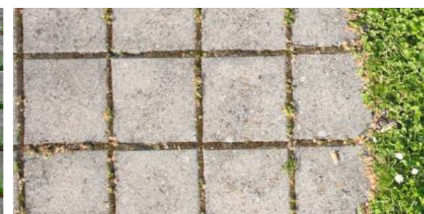
Pavés à joints drainants (gravier)
