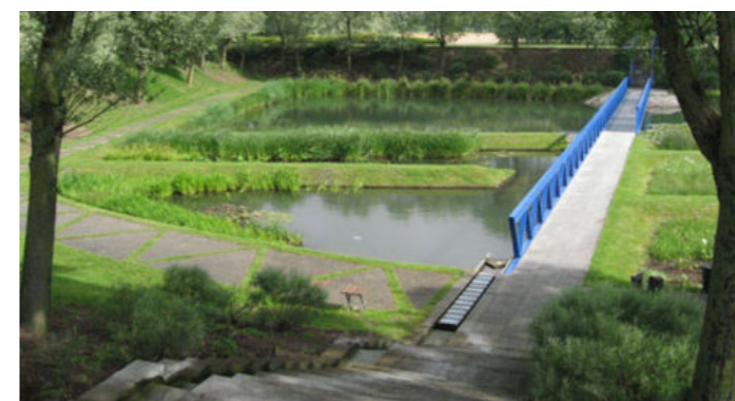
Bassin végétalisé de stockage des eaux pluviales
