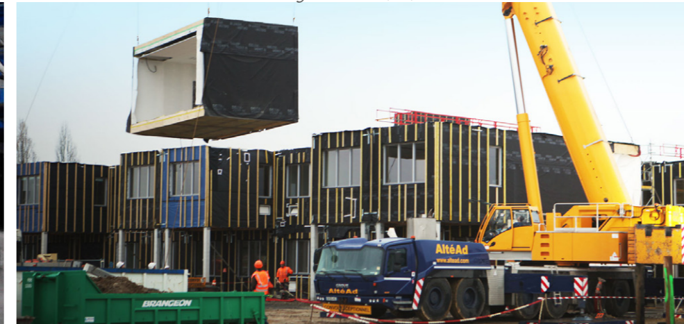
MISE EN PLACE SUR SITE - Collège Clisson (44)
