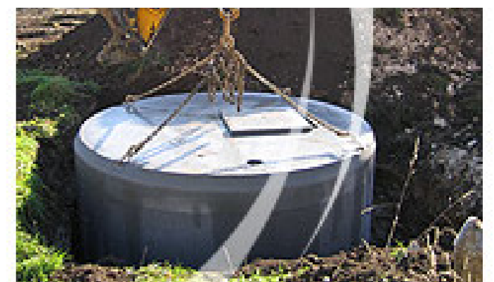
Cuve de récupération des eaux pluviales enterrée
