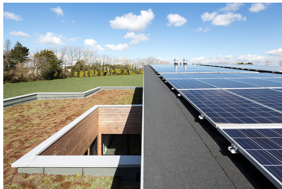
PANNEAUX PHOTOVOLTAÏQUES ET TOITURES VÉGÉTALISÉES, ÉCOPÔLE DE CONCARNEAU, FRANCE
