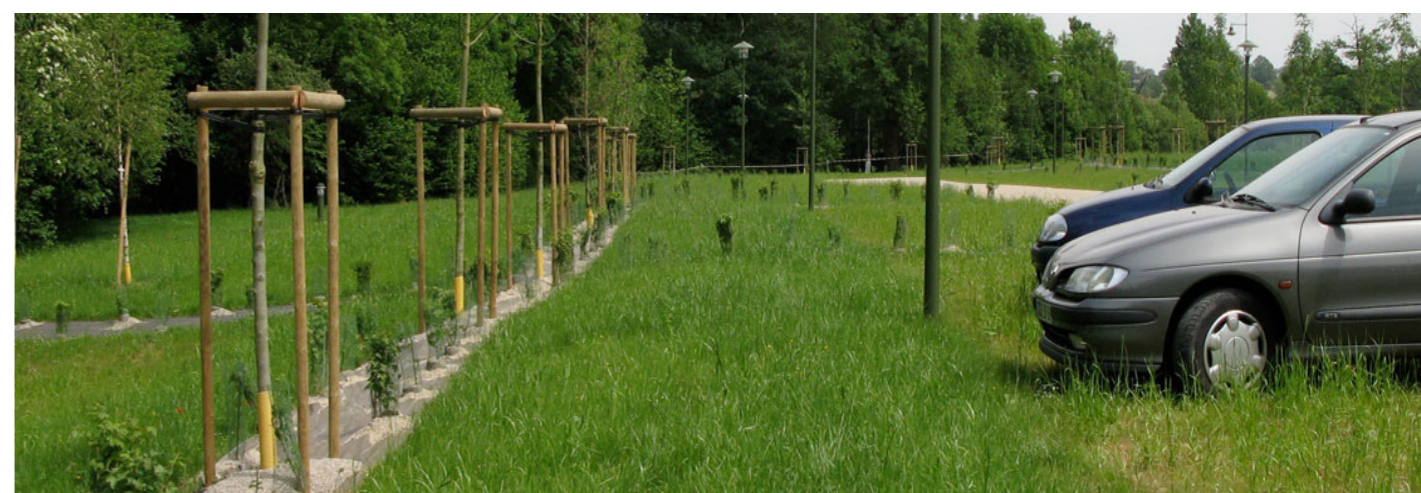
Parking sur prairie renforcée (engazonnement sur mélange terre-pierre compacté) adapté à une faible fréquentation.
