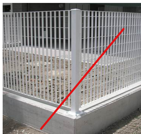
Clôture sur muret ne laissant pas passer la petite faune / Clôture laissant passer la petite faune
