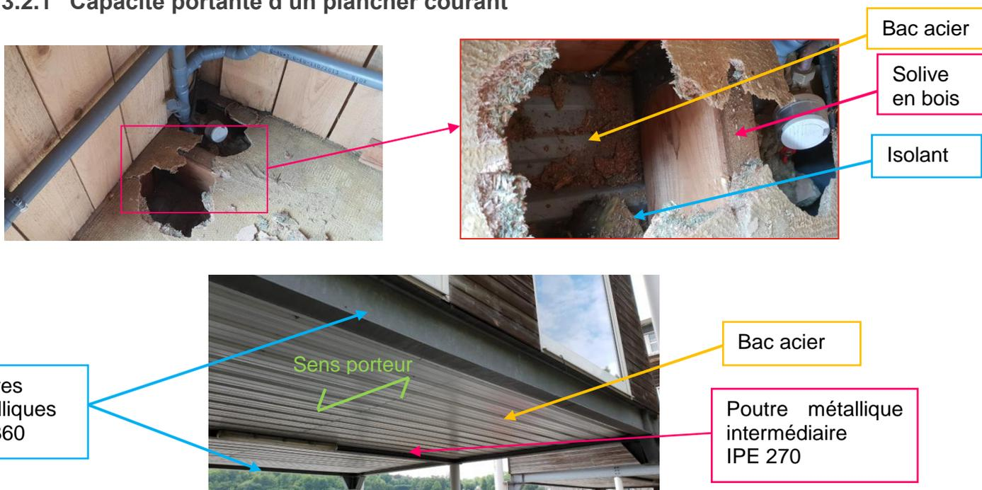
**Figure 7 : Descriptif de la composition d'un plancher courant**
