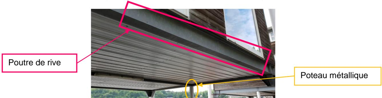
Figure 11 : Vue sur la poutre de rive
