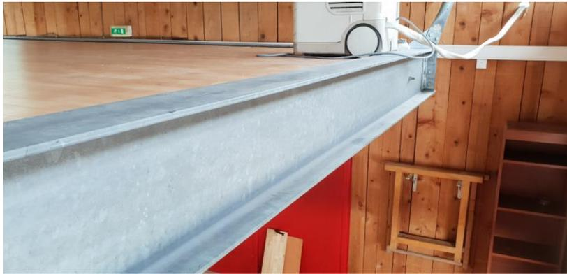
**Figure 13 : Poutre IPE de la mezzanine**
