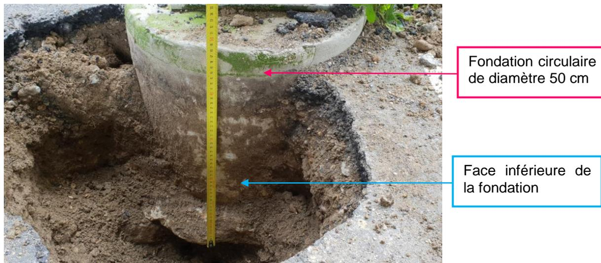
**Figure 19 : Fouille de fondation**
