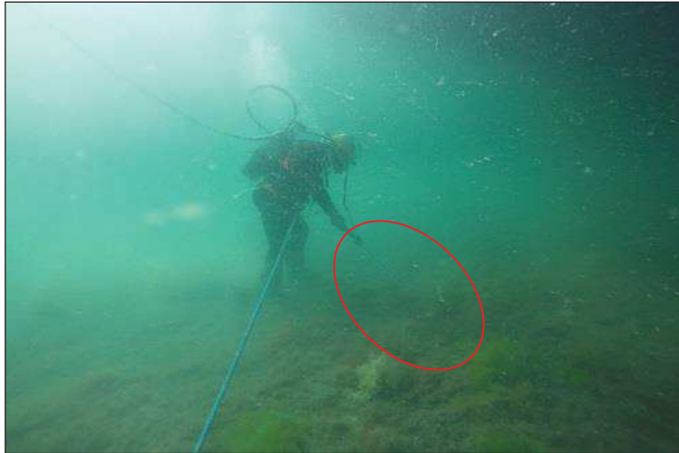
Mise en œuvre du MAGNEX 130B (Photos d'archives)
