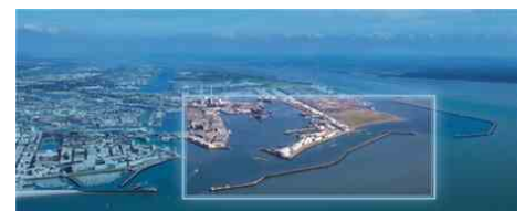
Une digue de 1,9 km de long et un chenal de 100 m de large pour l'accès fluvial. (photomontage Haropa )
