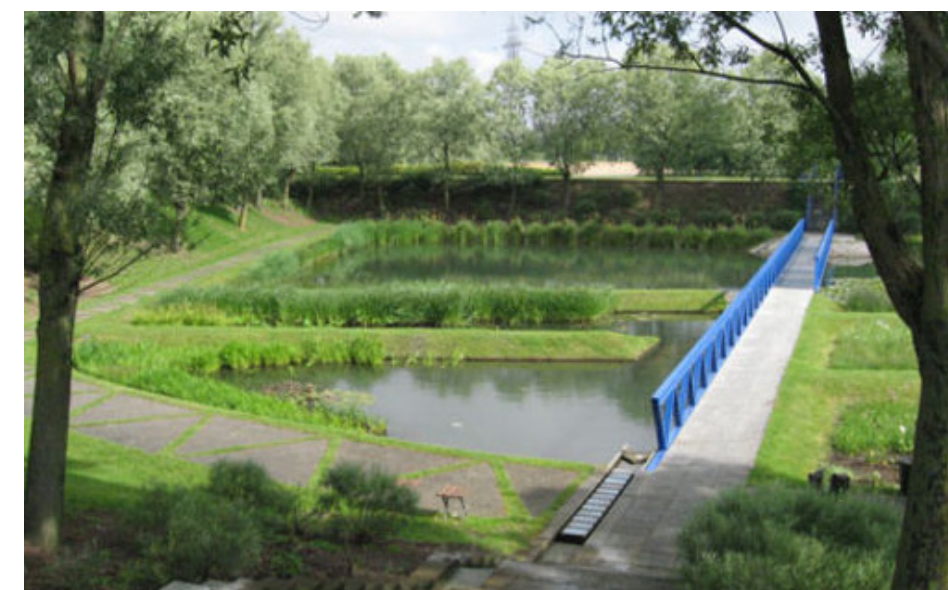
Bassin végétalisé de stockage et de dépollution des pluvielles
