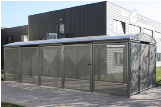
Abri vélos sécuritaire
