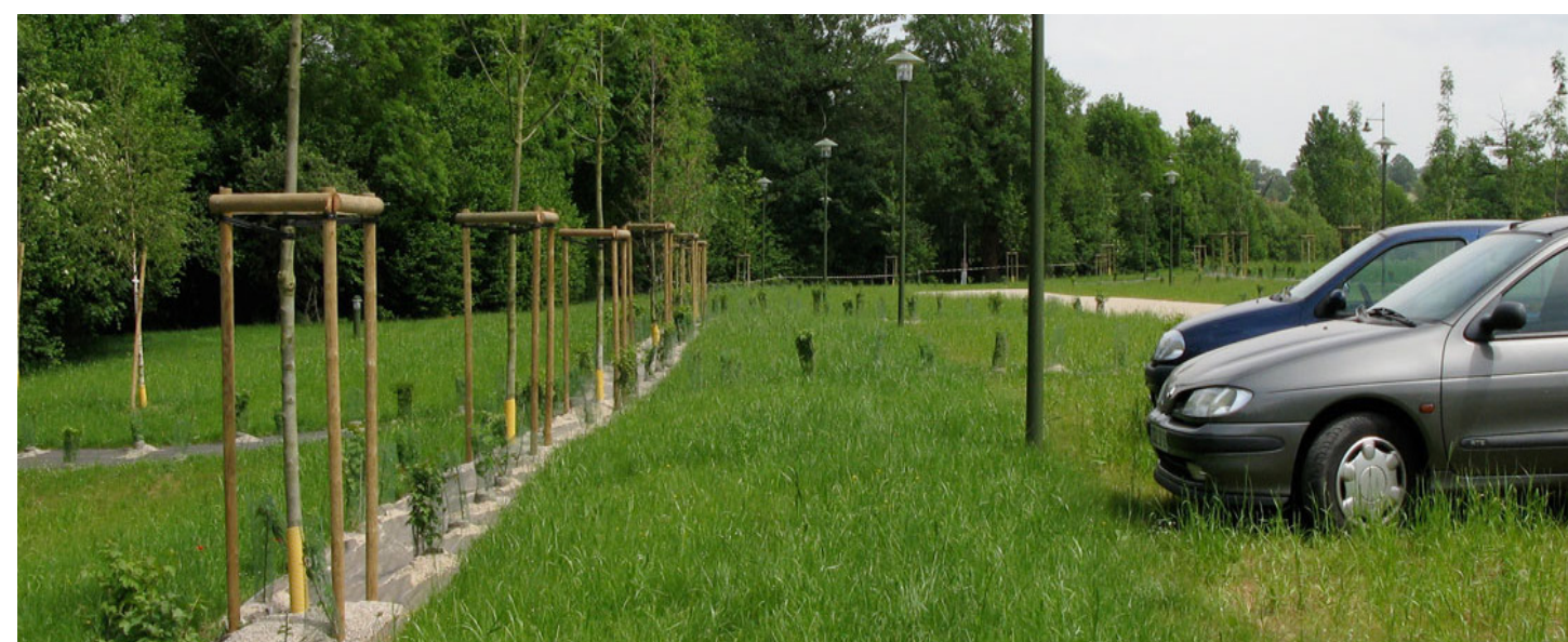
Parking sur prairie renforcée (engazonnement sur mélange terre-pierre compacté) adapté à une faible fréquentation.
