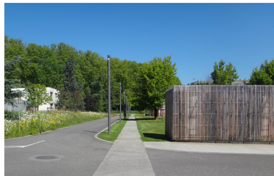
Locaux techniques en bois, Campus ISAE Toulouse
