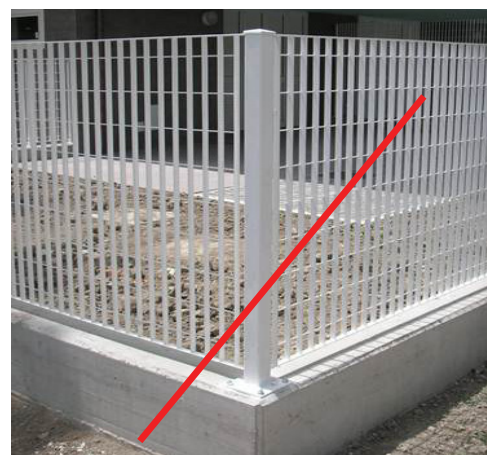
Clôture sur muret formant obstacle à la petite faune / Clôture laissant passer la petite faune
