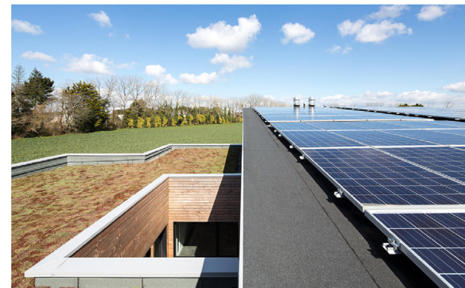
Panneaux photovoltaïques et toitures végétalisées, Écopôle de Concarneau
