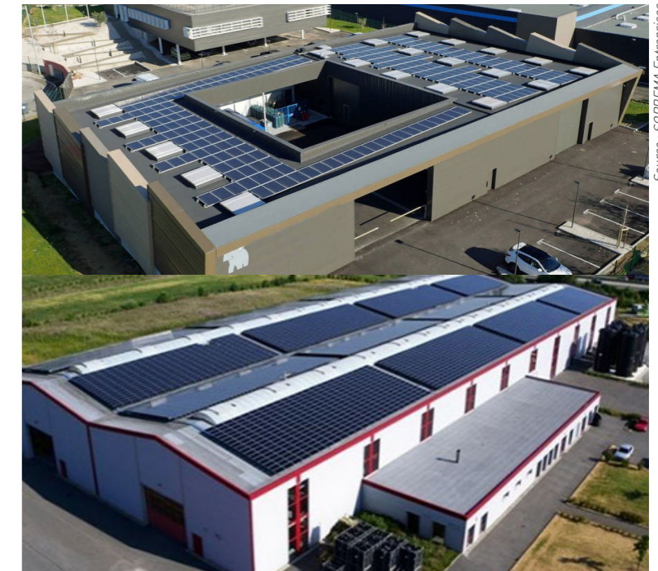
Installation de panneaux photovoltaïques en toiture de bâtiments industriels
