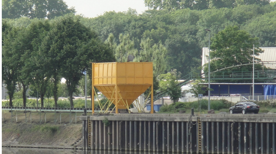
Les outils portuaires mis en peinture, Port de Bonneuil sur Marne
