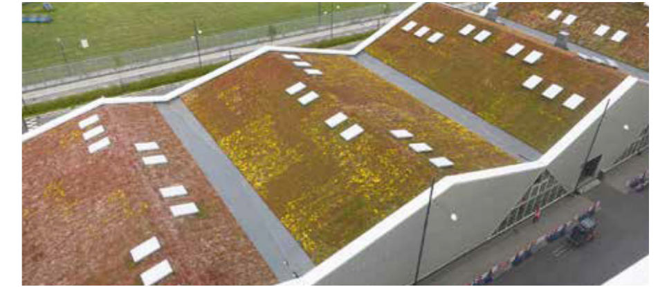
Toiture végétalisée d'un hangar à bateaux, Port de Copenhague - Malmö, Danemark
