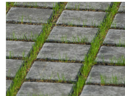
Pavés à joints engazonnés
