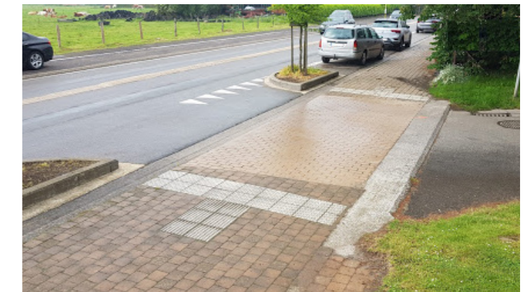
Trottoir traversant en zone résidentielle Changement de revêtement (couleur) marquant la traversée
