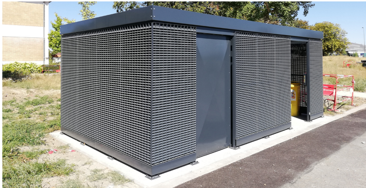
Locaux poubelles sur le port de Bonneuil
