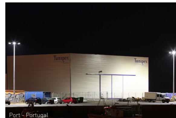
Port - Portugal Eclairage de zone industrielle : flux maîtrisé
