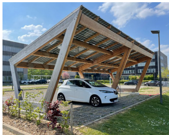
Exemple de stationnement désimperméabilisé (dalles ecoraster) avec installation d'une ombrière photovoltaïque structure bois. Une dimension de végétalisation complémentaire est intégrée au projet
