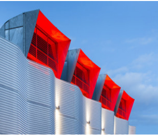
Aden-Architectes usine de ventilation
