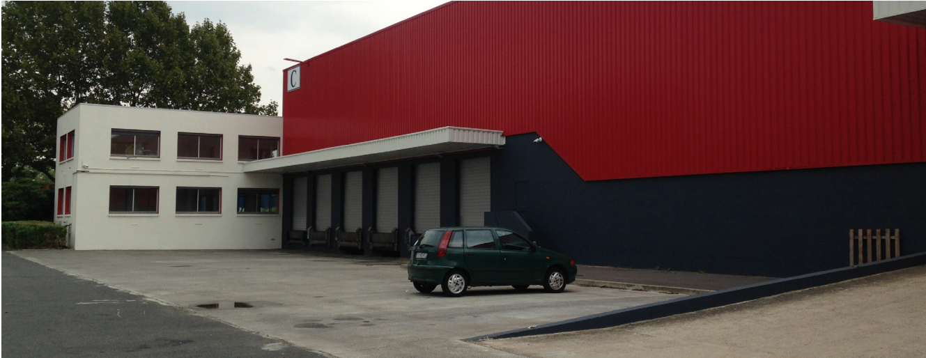
MISE EN APPLICATION DE LA PRESCRIPTION SUR LE PORT DE BONNEUIL - RAL 3000
