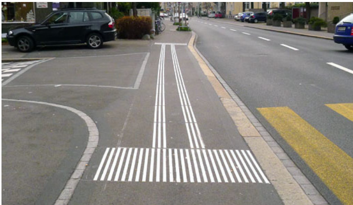
Trottoir traversant en milieu urbain Signalétique horizontale (marquage) marquant la traversée
