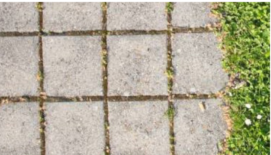
Pavés à joints drainants (gravier)
