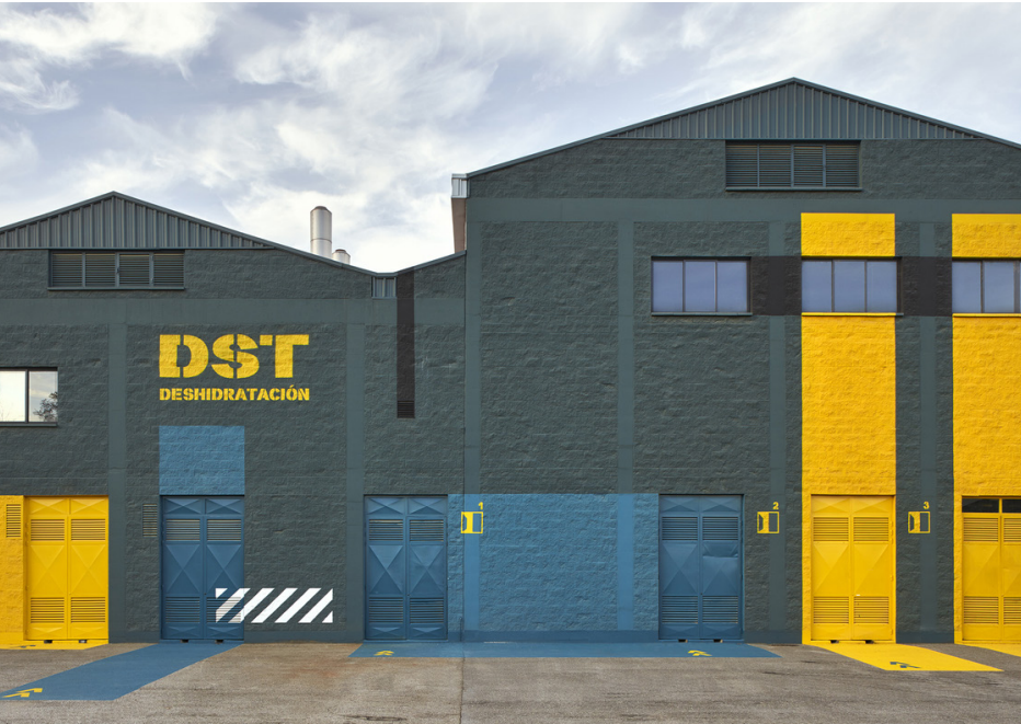
Industrial Remodelation at Villaperez / Padilla Nicás Arquitectos
