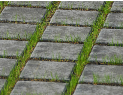
Pavés à joints engazonnés
