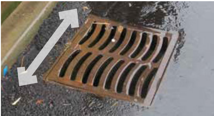
Grille d'égout avec des fentes inférieurs à 2 cm et éloignée d'au moins 10 cm par rapport à un point dur afin de permettre le passage (flèche blanche) de la faune et d'éviter les chutes.
