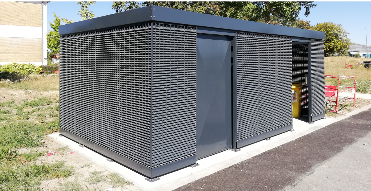
Locaux poubelles sur le port de Bonneuil
