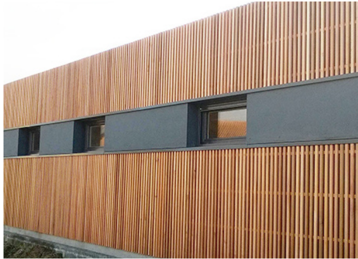
Source : http://www.strikto.fr Un autre matériau pour souligner l'encadrement des fenêtres
