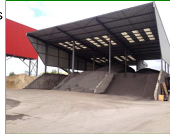
Couverture des stocks d'enrobés à Gennevilliers > SPME
