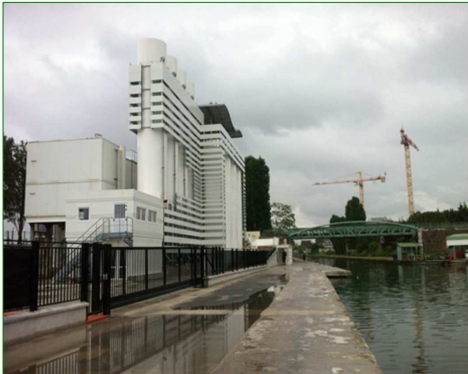
Accessibilité du bord à quai à Pantin - EQIOM
