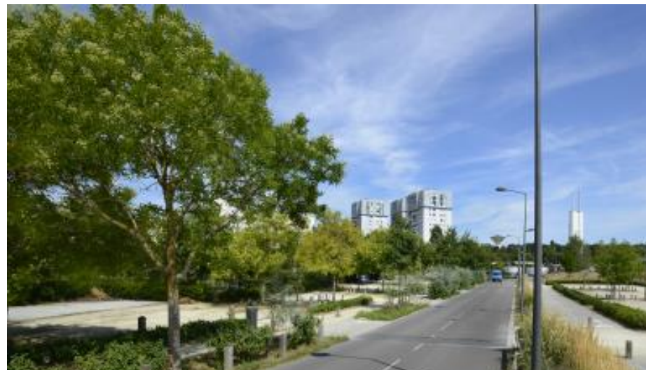
Bande de recul paysagère Les Mureaux – Infraservices
