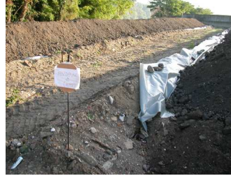
Mise en andain des terres souillées excavées – Route du Bassin n°6
