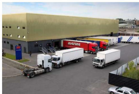
Source : Ports de Paris – Agence de Gennevilliers – Bâtiment C40
