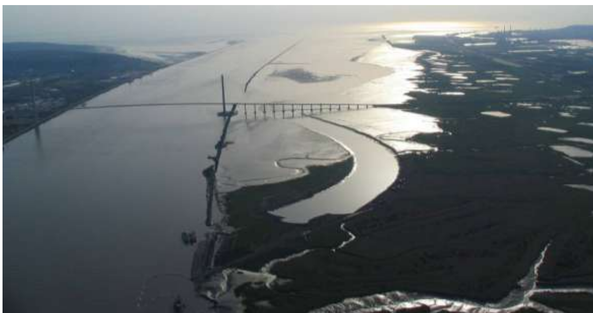
Figure 5. Situation en juin 2005 juste avant la fin du creusement du chenal environnemental (photo GPMH)
