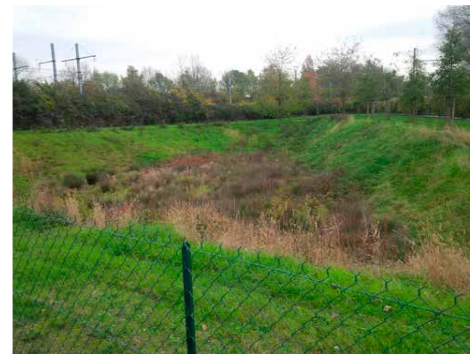
Bassin pour la gestion des eaux pluviales présent au fond de la parcelle 19 du lot 5, entre les voies RER A et embranchement ferré du port (voie unique). Il pourrait contribuer au futur corridor biologique entre le Bec de Canard et les délaissés/mesures compensatoires de la RN406.
