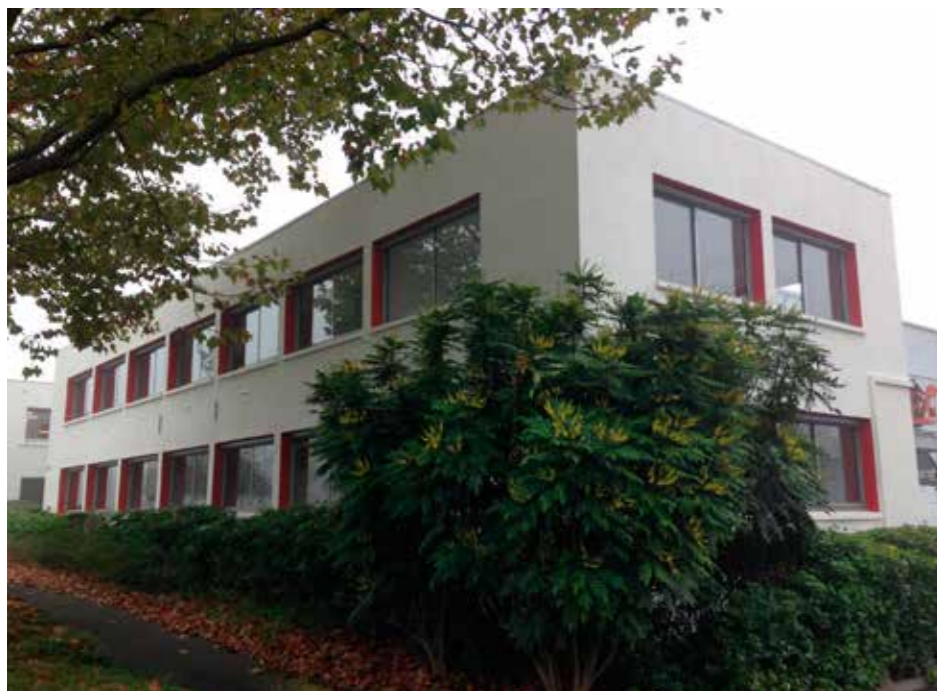
Bâtiment CC1 en cours de réhabilitation en 2017
