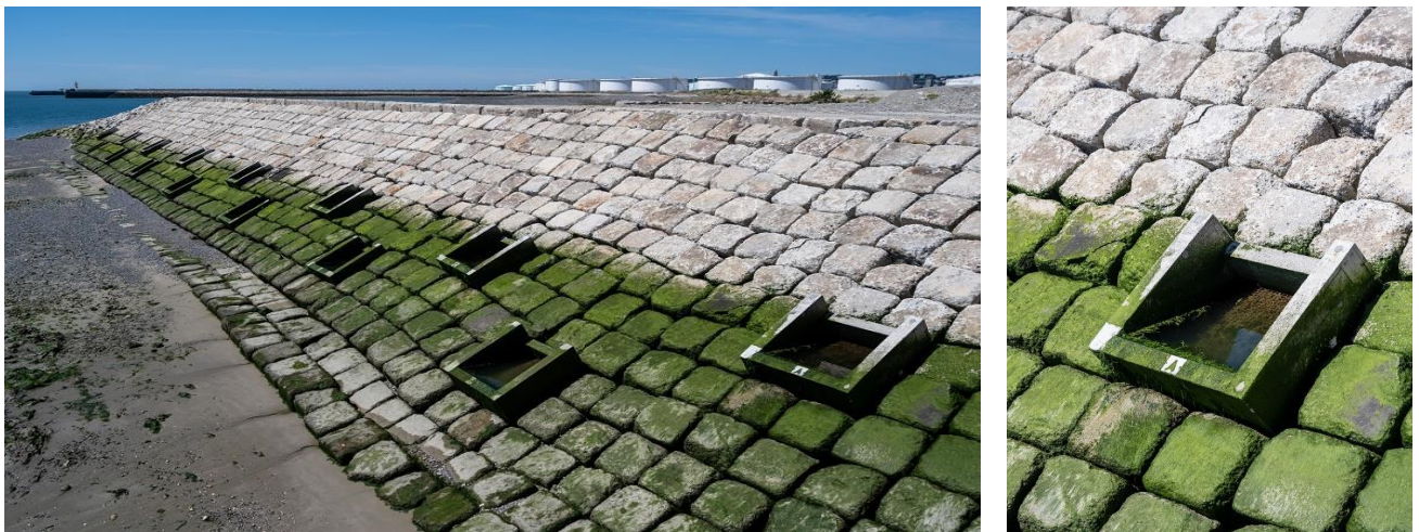
Modules d'habitats installés sur un renfort de talus de Port 2000 en illustration de ce qui sera installée sur la digue Chatière (MR08)
