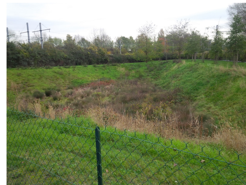
Bassin pour la gestion des eaux pluviales présent au fond de la parcelle 19 du lot 5, entre les voies RER A et embranchement ferré du port (voie unique). Il pourrait contribuer au futur corridor biologique entre le Bec de Canard et les délaissés/mesures compensatoires de la RN406.
