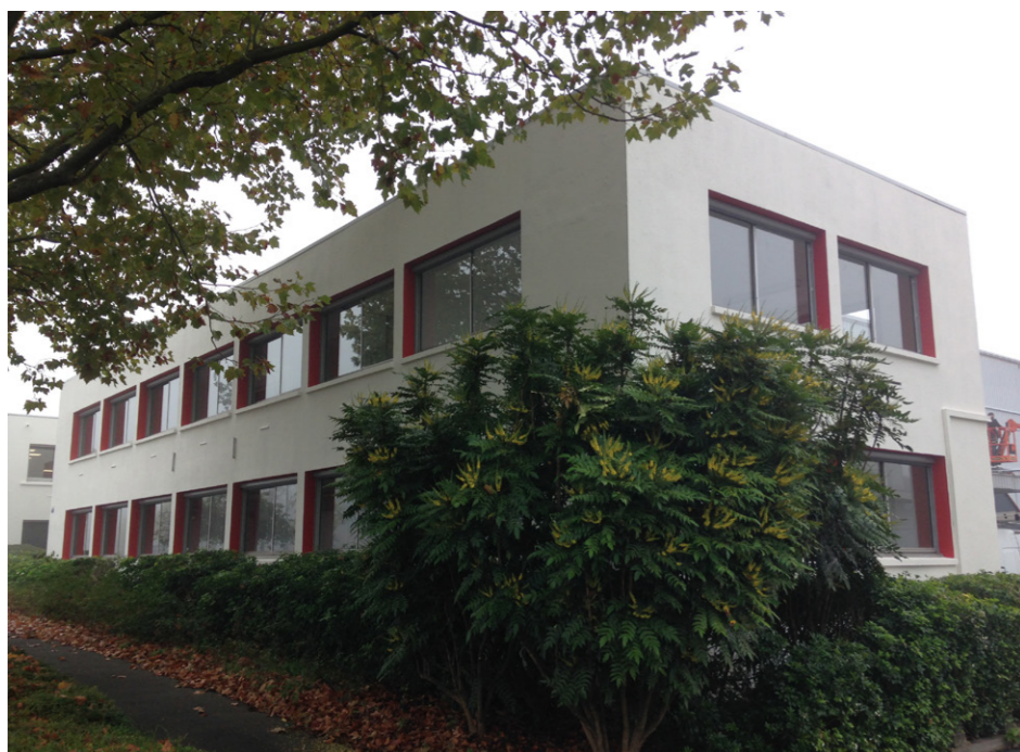
Bâtiment CC1 en cours de réhabilitation en 2017
